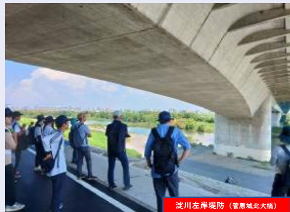
淀川左岸堤防（菅原城北大橋）
